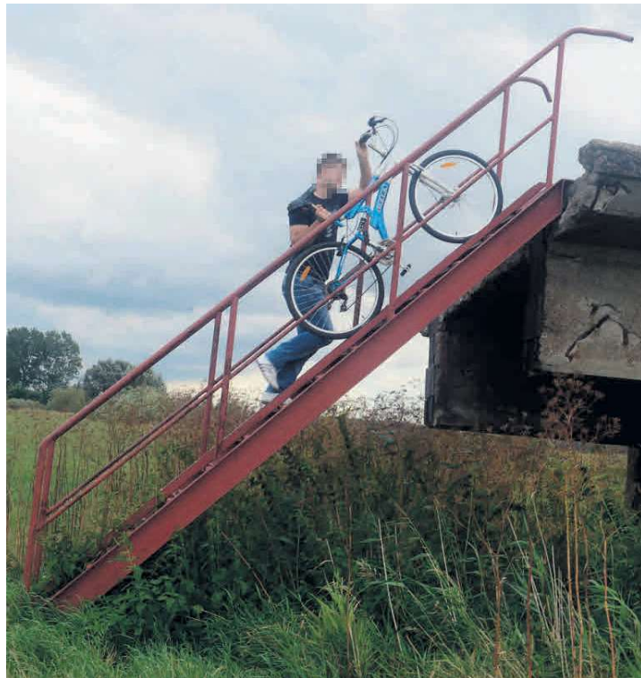
Markosice. To tutaj polscy i niemieccy strażacy zerwane przeszło mostu połączyli z niemieckim brzegiem Nisy schodami. Schody do Europy?
