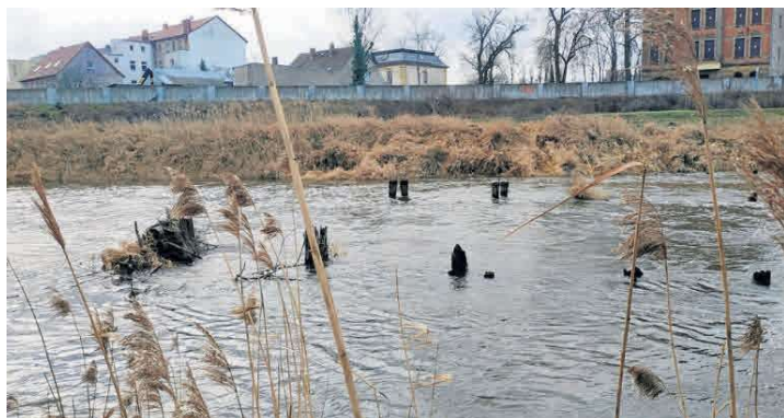
Oprócz istniejących już mostów dwa brzegi Nisy Łużyckiej w Gubinie spinała jeszcze jedna przeprawa. Na razie nikt nie mówi o potrzebie jej odbudowy
